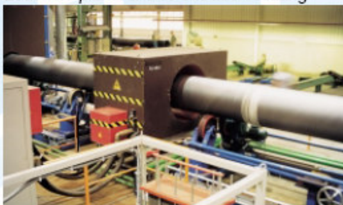
Impianto da 2500 KW per rivestimento a banda laterale 2500 KW plant for side extrusion coating
