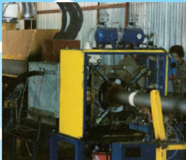
Instalación de 1000 KW para revestimiento de nylon Instalação de 1000 KW para revestimento.
